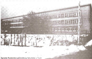
Zgrada Rudarsko-geološkog fakulteta u Tuzli
