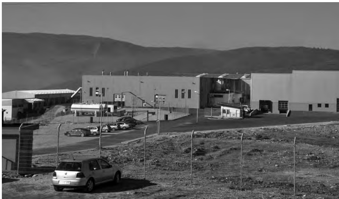
Hala za izradu betonskih prefabrikata
