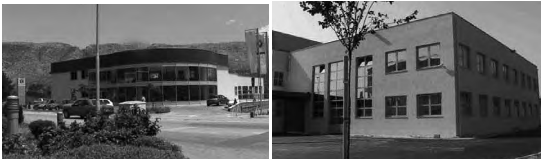
Slike 2.-3. Poslovne zgrade IGH-MOSTAR d.o.o. –
