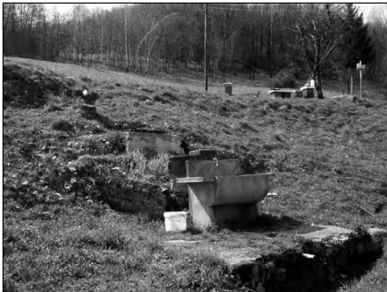
Sl.2 Kaptirani izvor u blizini ulaznog portala tunela
