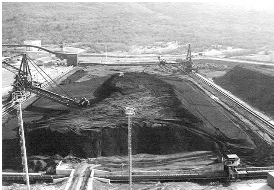
SLIKA 1.: Pogled na odlagalište ugljena s kotla TE Plomin 2; (u prvom planu transporter T6; lijevo: kombinirani stroj VOEST-ALPINE VASR 1200/45, Austrija, kapaciteta 1 200 t/h / 500 t/h uzima ugljen s većeg polja odlagališta; u pozadini desno: stari stroj STT-Trbovlje RD30, Slovenija, kapaciteta 350 t/h / 350 t/h i manje polje odlagališta; u pozadini lijevo: presipni toranj PT3 s cijevnim transporterom iza kojeg je zgrada filtarske stanice rashladne morske vode)
